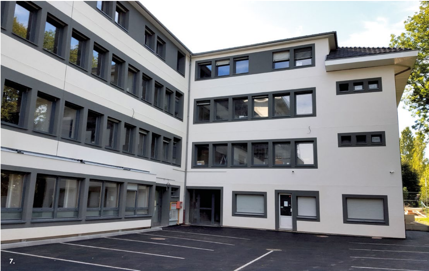
7. Crédit Agricole - Vesoul (70) Architecte : Cabinet HBI. 8. OPAC Confluence - Lyon (69) Architecte : E. Colboc
