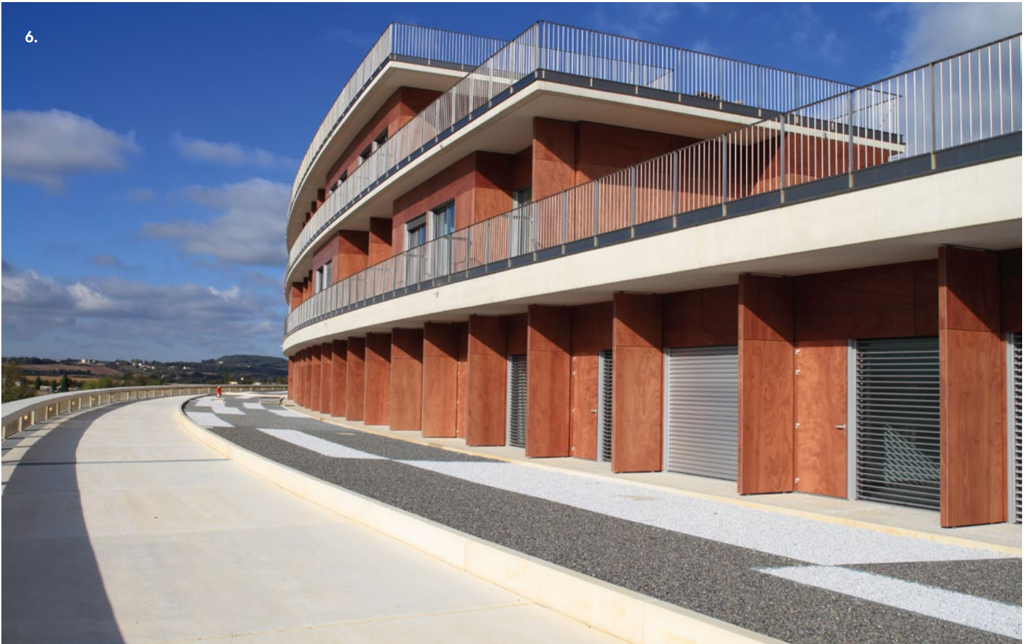
5. Auvent - Porte des Lilas - Paris (75) Architecte : Intégrale 4. 6. Hôpital CHIC - Castres-Mazamet (81) Architecte : Agence Viguié
